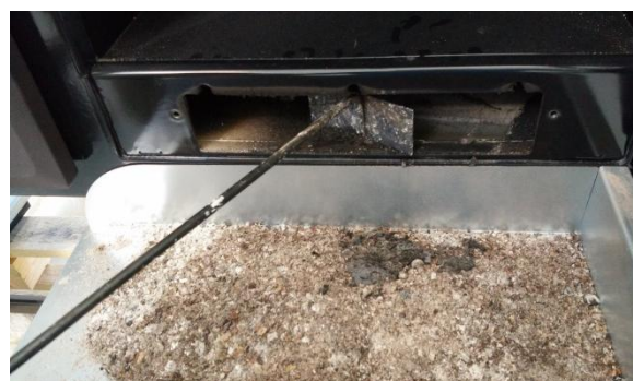
Figure n°14 - Accès pour le nettoyage de la sortie de fumée
