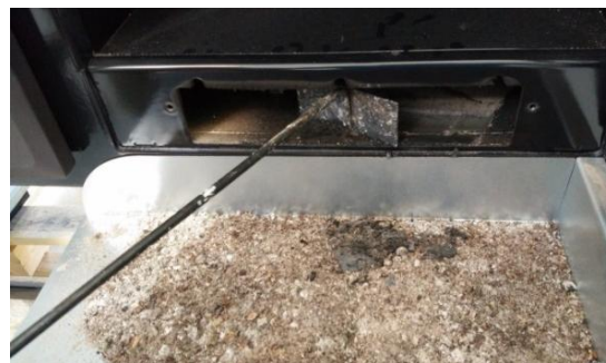
Figure n°12 - Accès pour le nettoyage de la sortie de fumée
