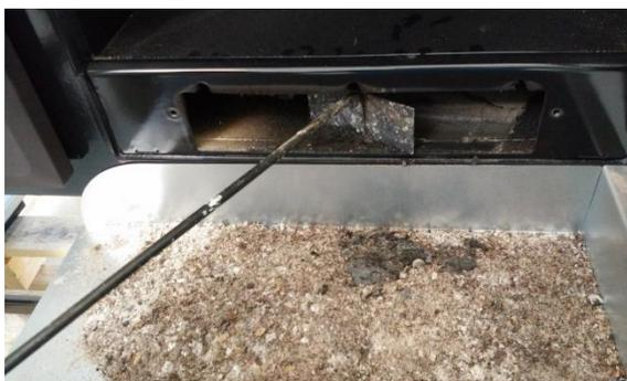
Figure n°15 - Accès pour le nettoyage de la sortie de fumée
